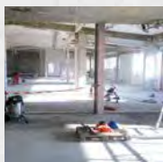
Sanering van pilaren
