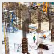
na 7 dagen op vers beton inzetbaar
