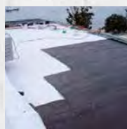
Afdichting op bitu- mendak
